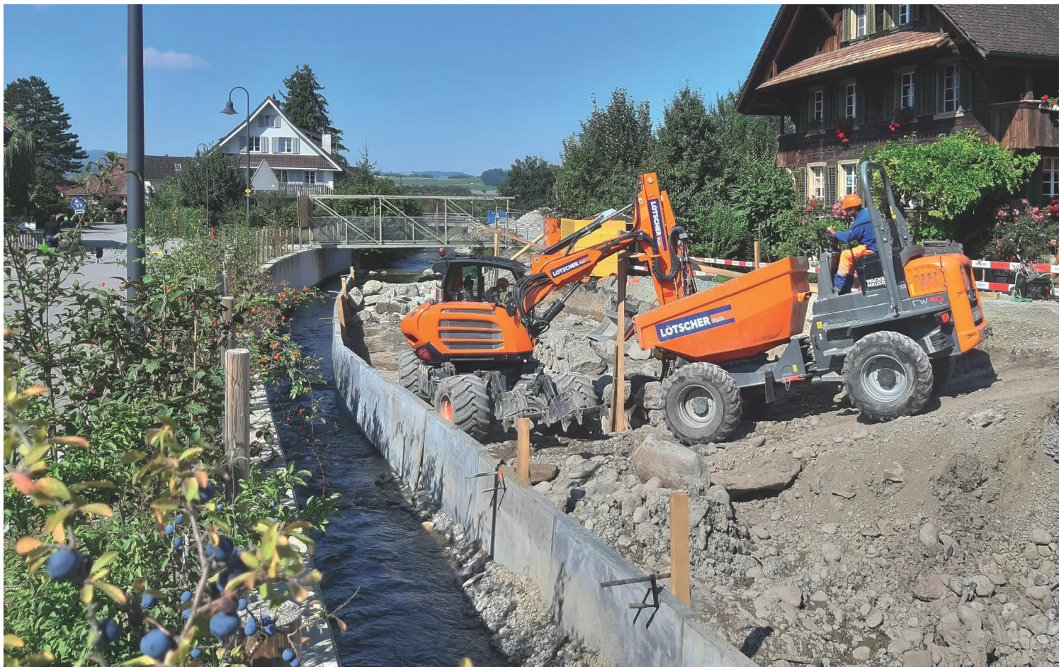
Bauarbeiten für den Hochwasserschutz im Bereich des Försterhauses an der Dorfstrasse
