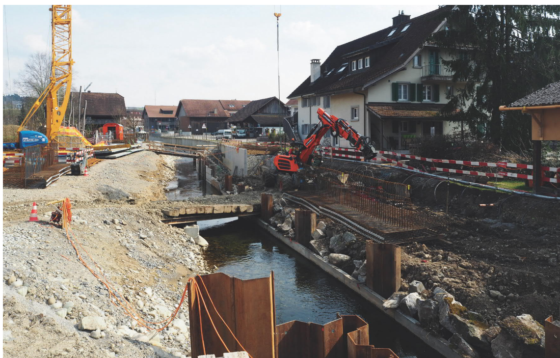
Erneuerung der Ufermauern oberhalb der Mattenhofbrücke
